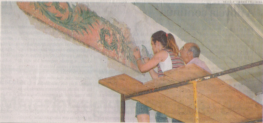
SOB CAL, ARTE E HISTÓRIA | Restauradores retiram a cal da parede e vai surgindo a preciosa pintura original
