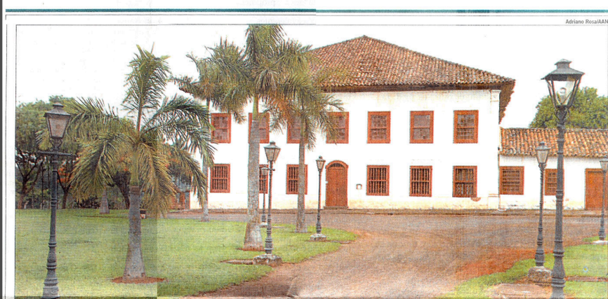
Parte da história da região, o Casarão do Salto Grande, em Americana, passa por reforma prevista para ser finalizada em 2010 a um custo total estimado em R$ 5 mil
